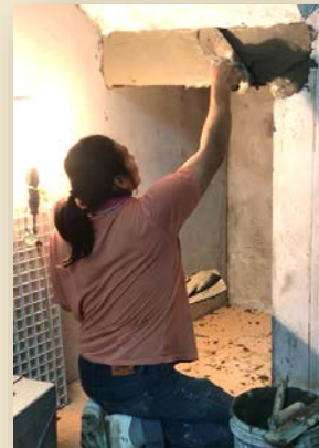
圖 2、水泥抹強示意圖
